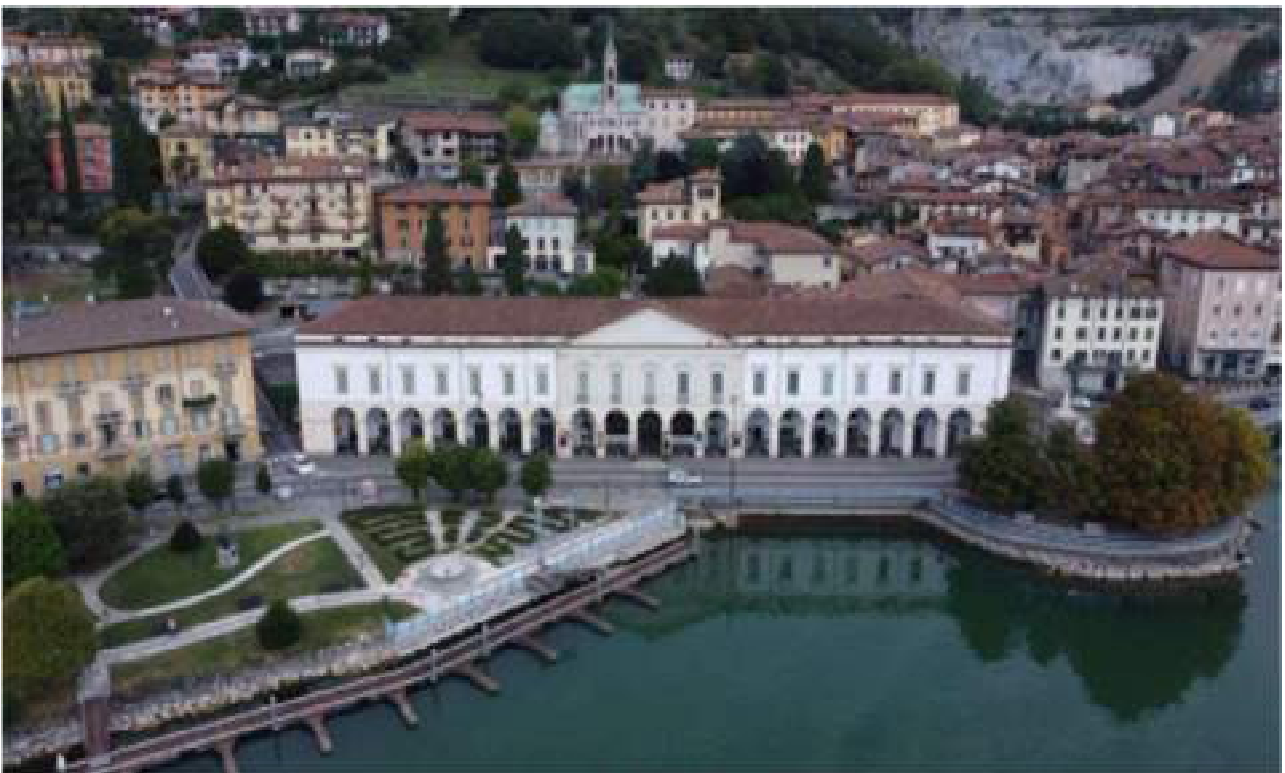
Sopra, la facciata di palazzo Tadini, oggetto di lavori di restauro nel 2019.
